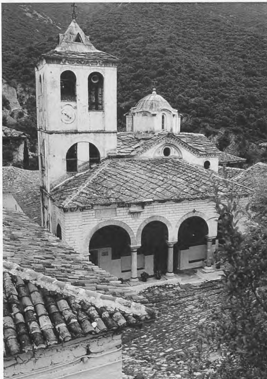
Άποψη του καθολικοῦ τῆς μονῆς Τιμίου Προδρόμου ἀπό τά δυτικά.
